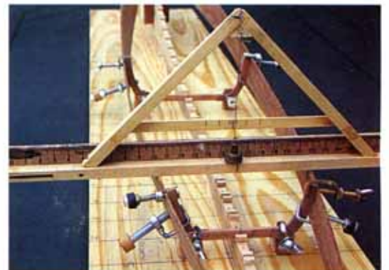
Contrôle de l'inclinaison du maître couple avant à l'aide du fil à plomb.
