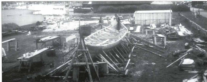
Cantiere, presso il fiordo di Roskilde, per la costruzione delle repliche delle navi di Skuldelev
