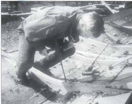
Esecuzione di un foro con l'uso della ricostruzione di un trapano di età medievale su una replica delle navi di Skuldelev (Roskilde, Danimarca)
